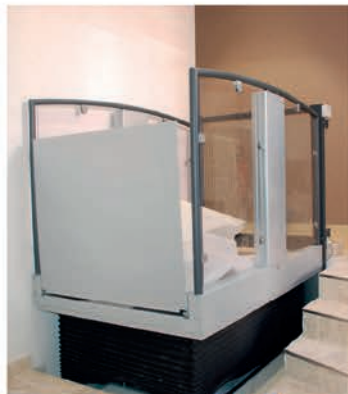
Plateforme permettant aux PMR l'accès à la salle de réunion de la préfecture de l'Ariège
