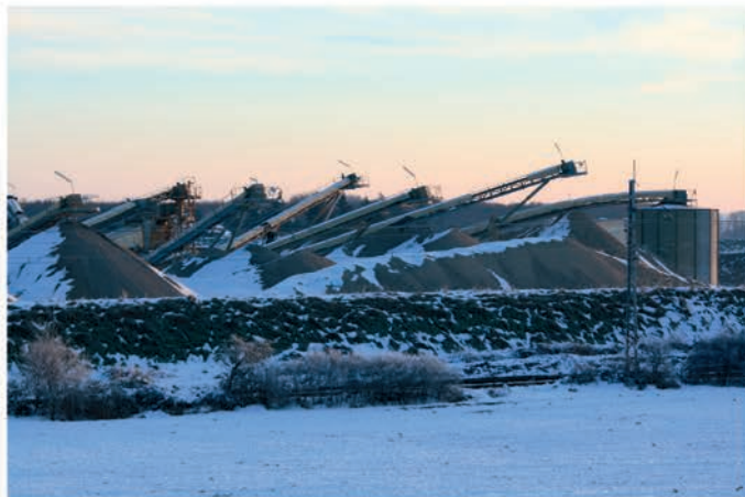
Installations de concassage sous la neige Saverdun
