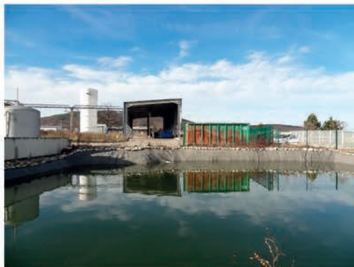
Vue du bassin d'orage et du hangar de dépotage
